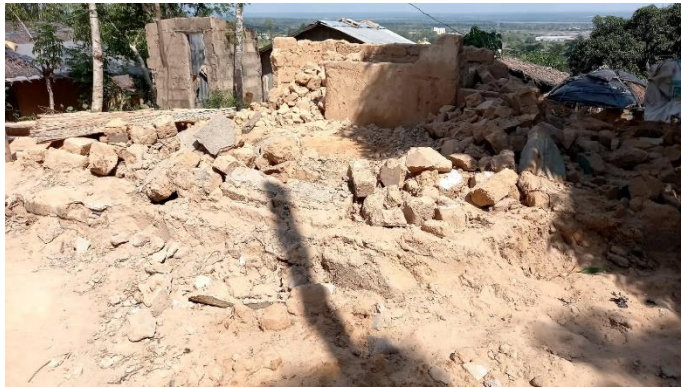
Casa de um irmão completamente destruída pelo ciclone
